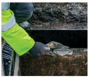
L'alternative respectueuse de l'environnement aux matériaux à base de résine, formulée spécifiquement pour la pose de panneaux d'accès.
